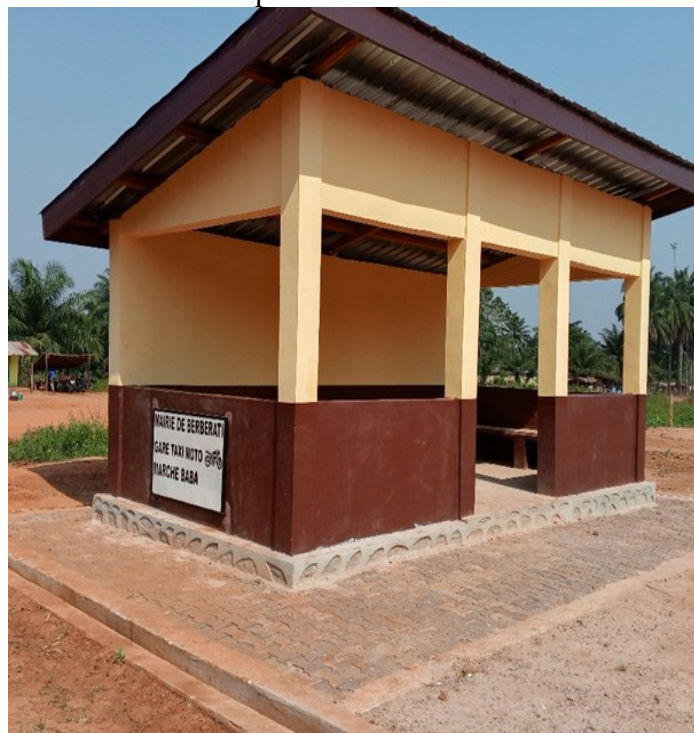
Abris moto et kiosque solaire
