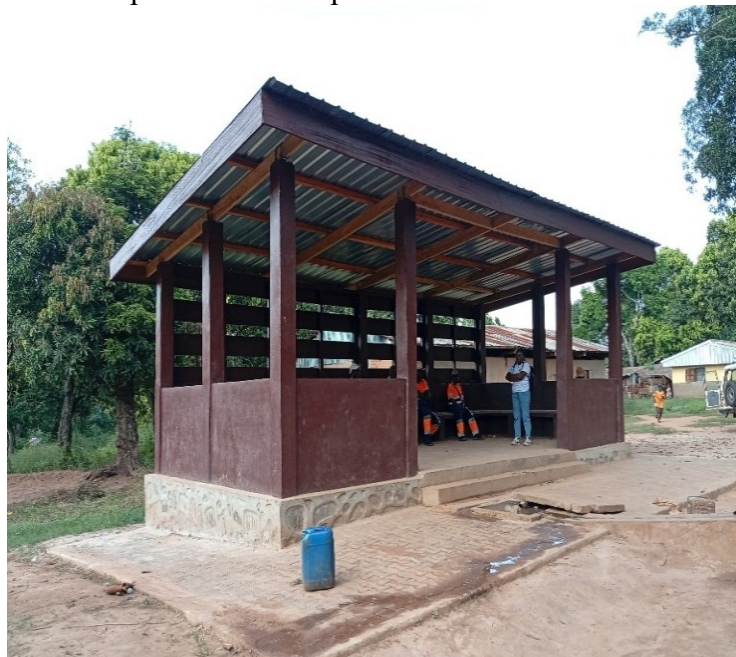
Nouveau point d'eau au quartier Ndao
