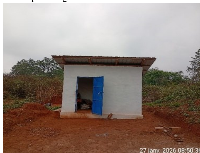
Abrite pour le gardien du site de déchet
